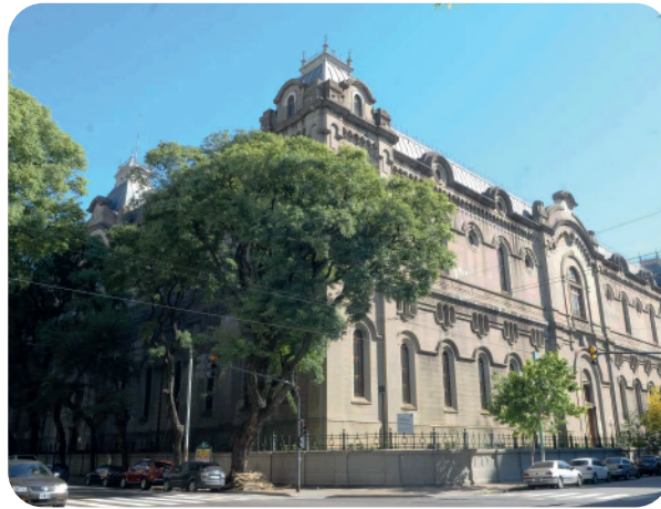
DEPÓSITO DE GRAVITACIÓN
